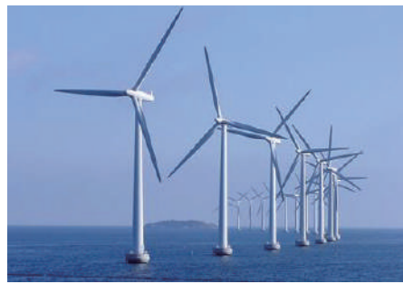
海上風力発電設備
