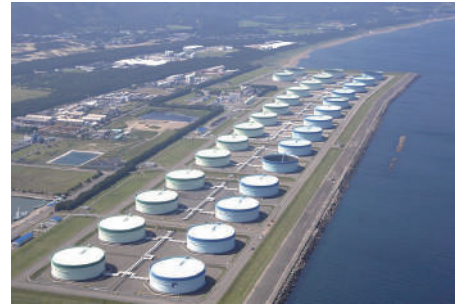
石油備蓄基地
