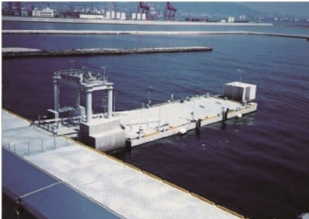
栈橋などの海洋構造物
